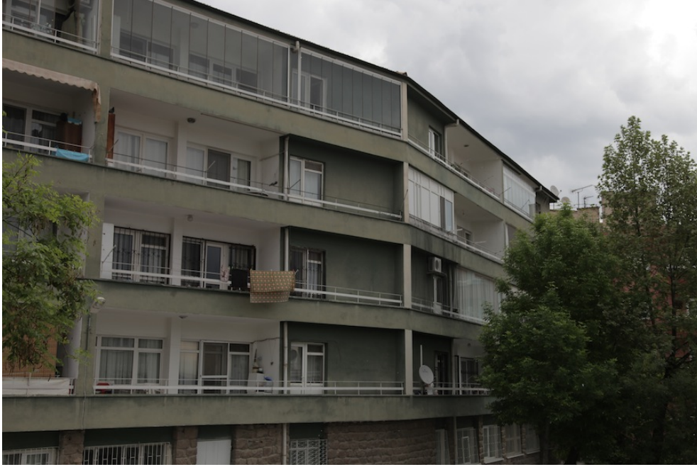
Resim 3 –Konservatuar Evleri , B Blok Cephe Görünümü
