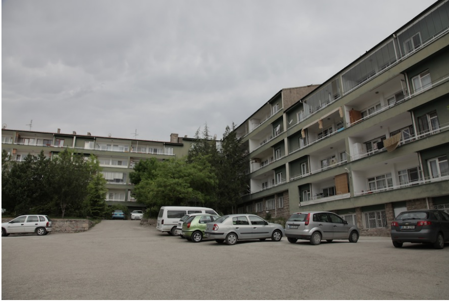
Resim 1- Konservatuar Evleri , A Blok-B Blok Cephe Görünümü
